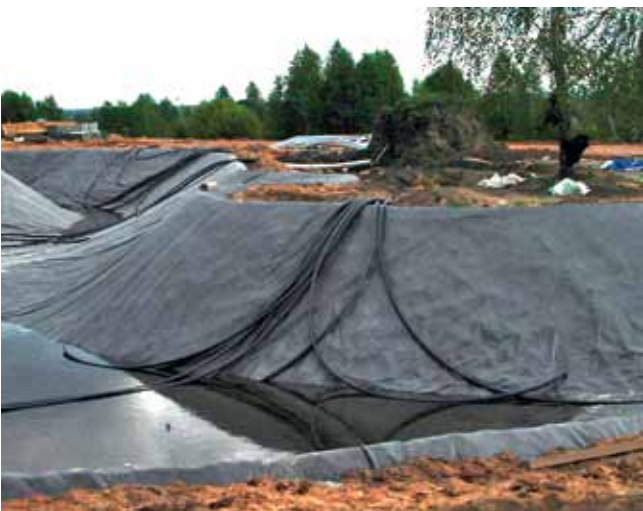
Водоем с пленочной гидроизоляцией
