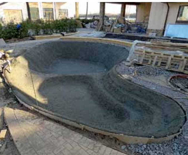
Водоем с гидроизоляцией из бетона
