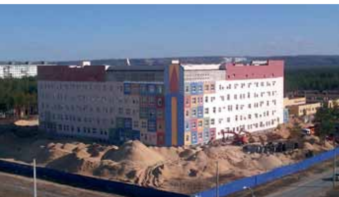
Строительство перинатального центра в г. Дзержинске
